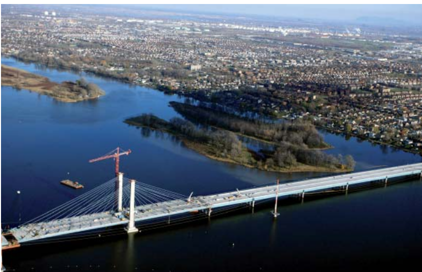
Vue aérienne du pont en construction de l'autoroute 25
